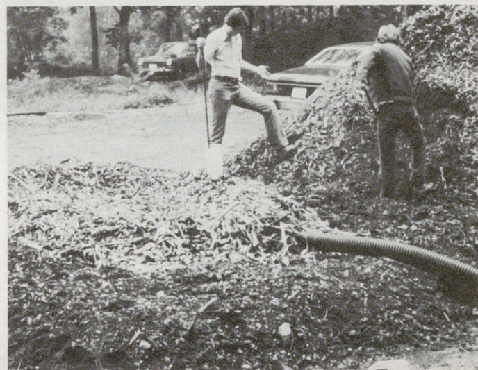
Le caillebotis est prêt à recevoir le mélange de déchets destinés au compostage.
