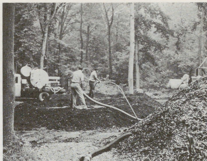
Les déchets sont déversés sur les liants moulés en forme de plat. L'absorption dure 30 minutes environ.
