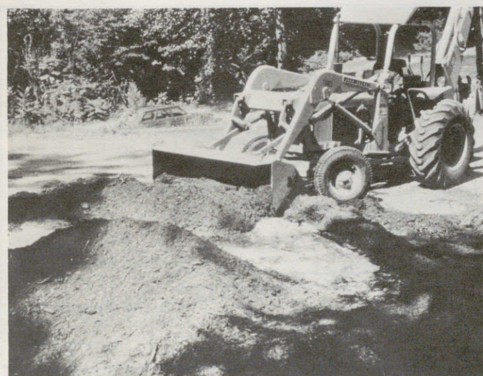
Mélange des liants et des déchets.
