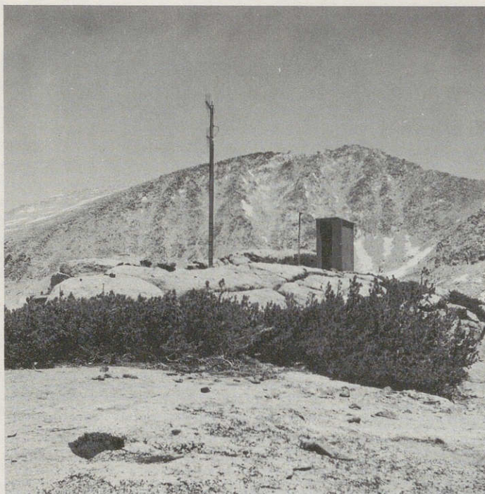
Fig. 5. Izq.: Instalación de una repetidora en el campo de los Parques Nacionales Sequoia y Kings Canyon, y la unidad de repetición con célula solar y acumulador.
