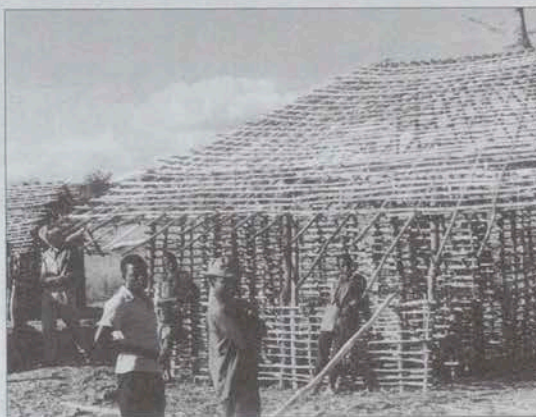
Conhecimento local e envolvimento comunitário na construção do Posto de Fiscalização em Puila, distrito de Sanga, Niassa
